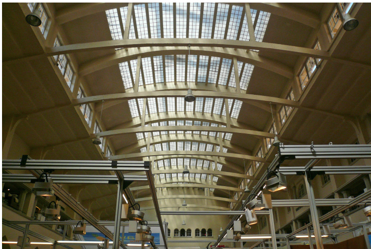
Dachkonstruktion der Markthalle Stuttgart – die Dachkonstruktion unseres Festsaaals wäre deutlich schöner und filigraner. (Foto: Armin Stingl)
