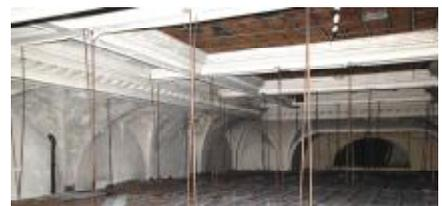
Die Stuckdecke des Festsaals ist abgehängt, aber gut erhalten, oben das bedeckte Glasdach
